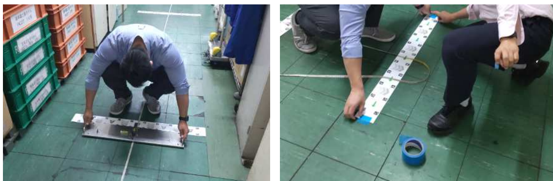
AR マーカーの貼り付け作業の様子
